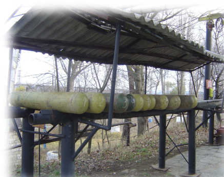
Figura 7: Depozitarea clorului
