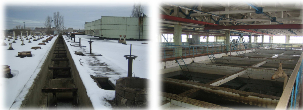
• Figura 6: Stația de tratare a apei STA
