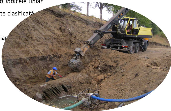
Figura 9: Spărtură pe o conductă din ciment de DN 1200 cu blocarea drumului
