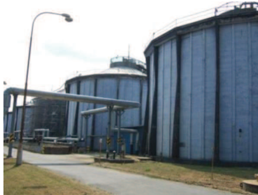
Figura 15 Fermentatoare la SEAU din Praga (Republica Cehă)
