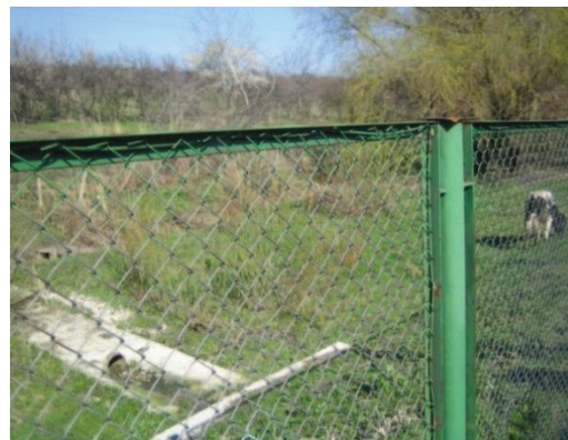
Evacuarea apei epurate într-un mic râu din apropiere
