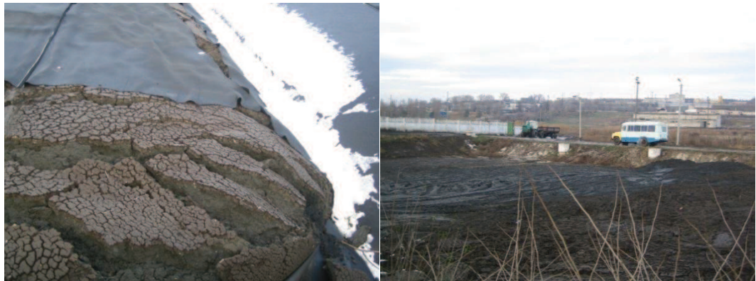
Geotub deschis înainte de manipularea nămolului.
