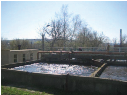
Bazin de stabilizare a nămolului primar
