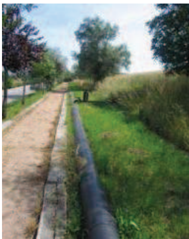
Figura 23 Conducte de colectare și sistem de ardere a biogazului la rampa de gunoi SERAF (Franța)
