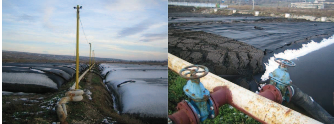
Geotuburi cu linie de alimentare nămol.
