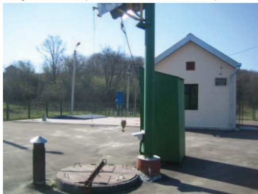
Vedere generală asupra SEAU Goianul Nou
