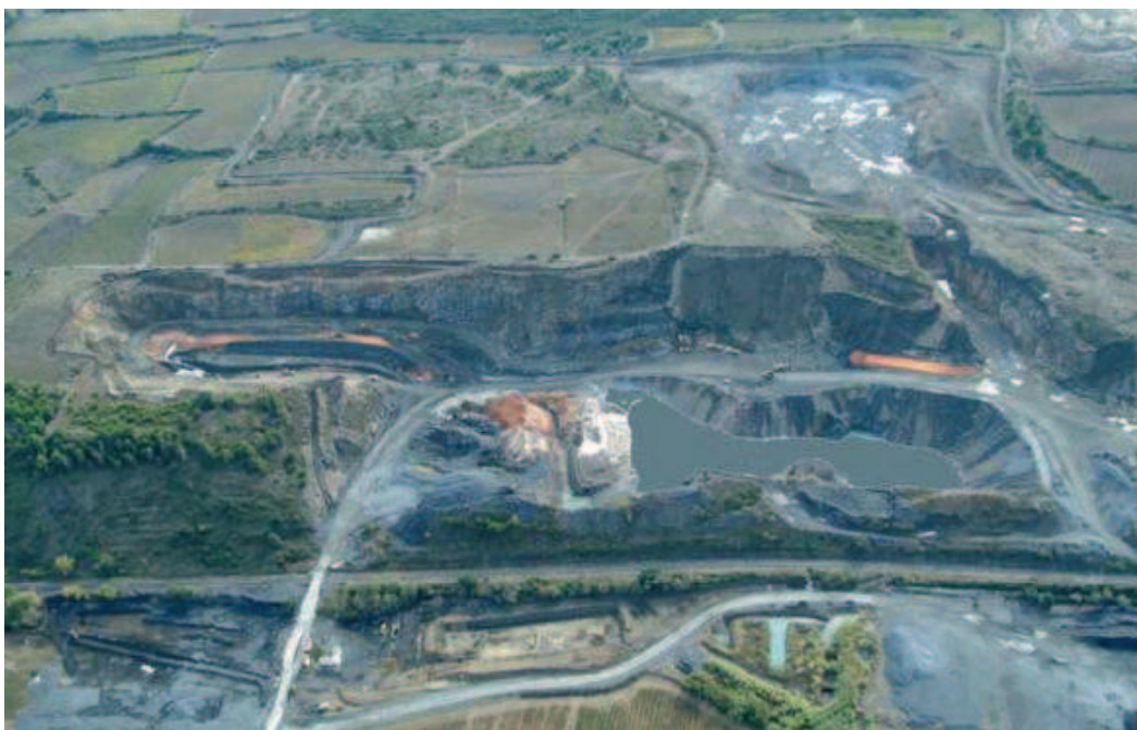
Figura 24 Exemplu de rampă de gunoi amplasată într-o fostă carieră (Espira de l'Agly, Franța)
