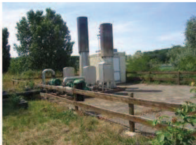
Figura 23 Conducte de colectare și sistem de ardere a biogazului la rampa de gunoi SERAF (Franța)
